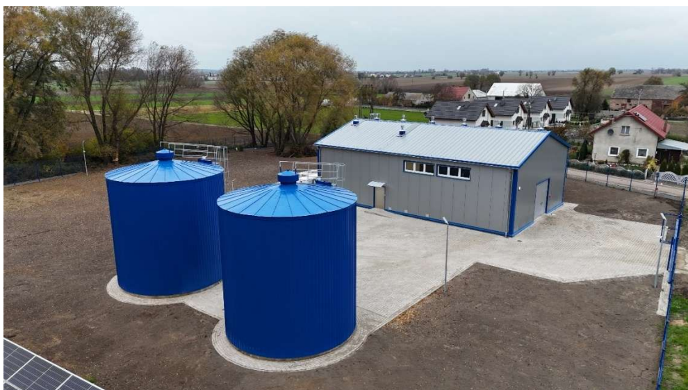
Rysunek 73. Stacja Uzdatniania Wody w Raciborowie po przebudowie
